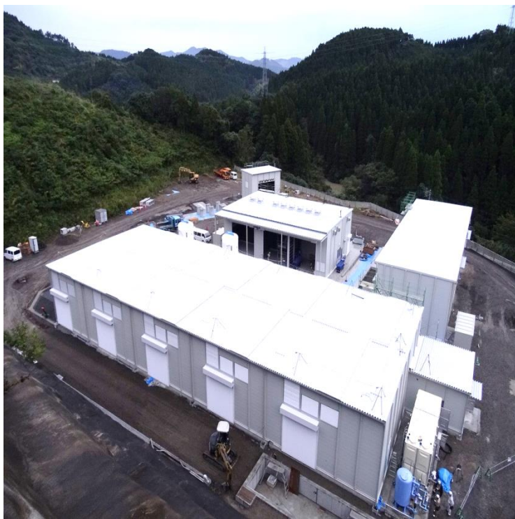
現在施工中の現場（11/2現在）
